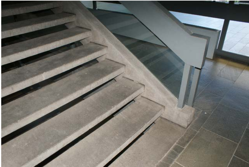
Bild 3: Physik 2, EG Treppenhaus (Probe B), Fuge an Treppenstufen.
