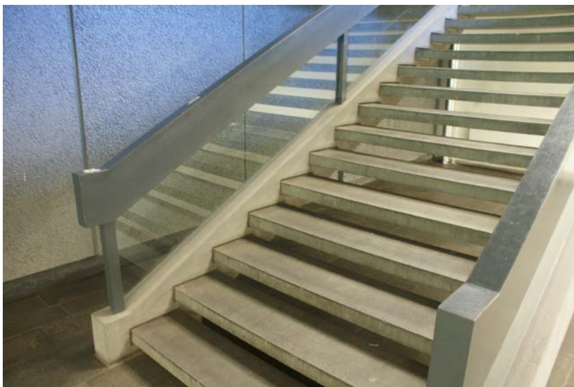
Bild 6: Hörsaal-Abgang zu den Toiletten, EG/KG (Probe D), Fuge an Treppentufen.
