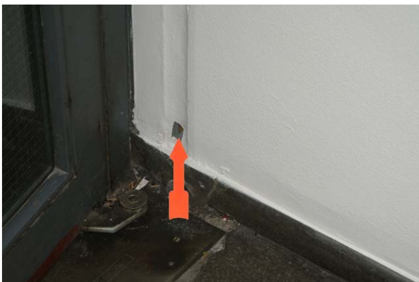
Bild 2: Physik 2, EG Treppenhaus (Probe A), Detailansicht.
