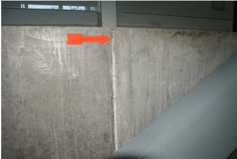
Bild 5: Physik 2, EG Treppenhaus (Probe C), Fuge an der Verkleidung des Treppenauges.
