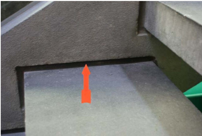
Bild 12: Theoretische Physik, EG Treppenhaus (Probe H), Fuge an Trep- penstufen, Detailansicht.
