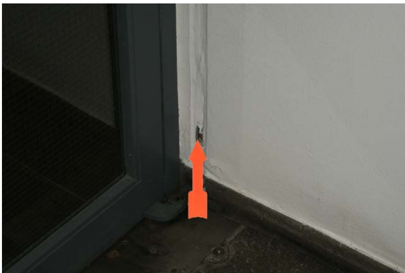
Bild 8: Physik 1, EG Treppenhaus (Probe E), Wandfuge.
