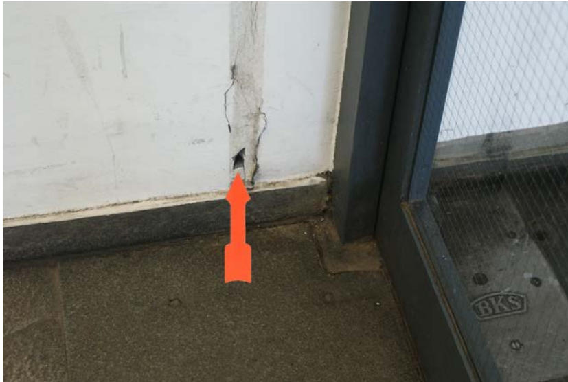
Bild 15: Kernphysik, EG Treppenhaus (Probe J), Wandfuge, Detailansicht.
