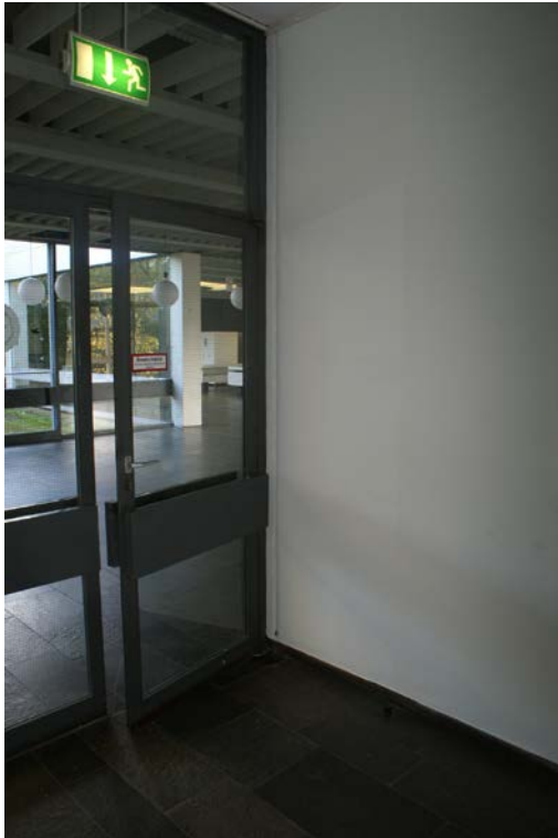
Bild 1: Physik 2, EG Treppenhaus (Probe A), Wandfuge.
