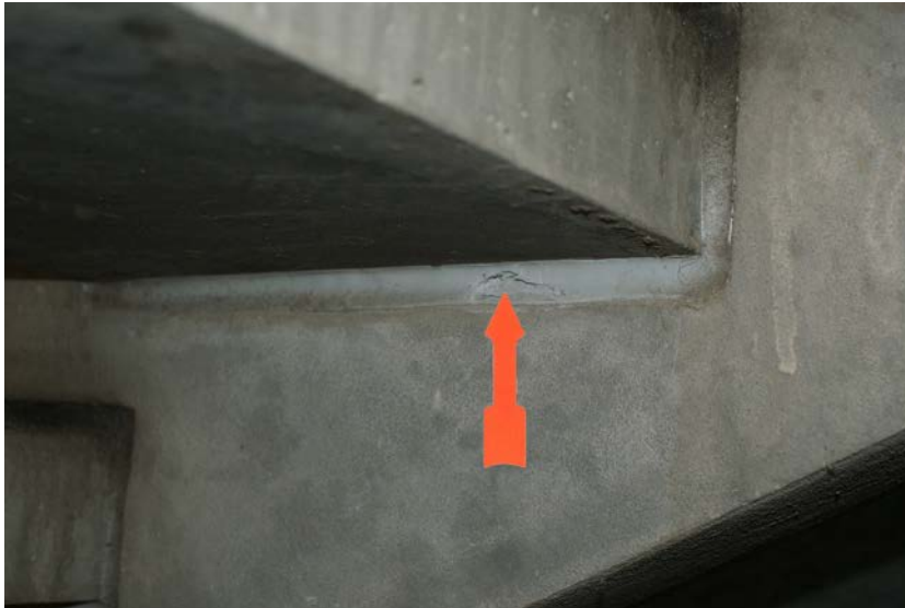
Bild 7: Hörsaal-Abgang zu den Toiletten, EG/KG (Probe D), Fuge an Treppenstufen, Detailansicht.
