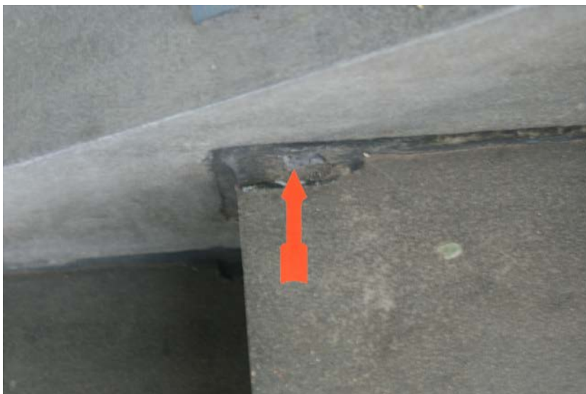
Bild 16: Kernphysik, EG Treppenhaus (Probe K), Fuge an Treppenstufen, Detailansicht.
