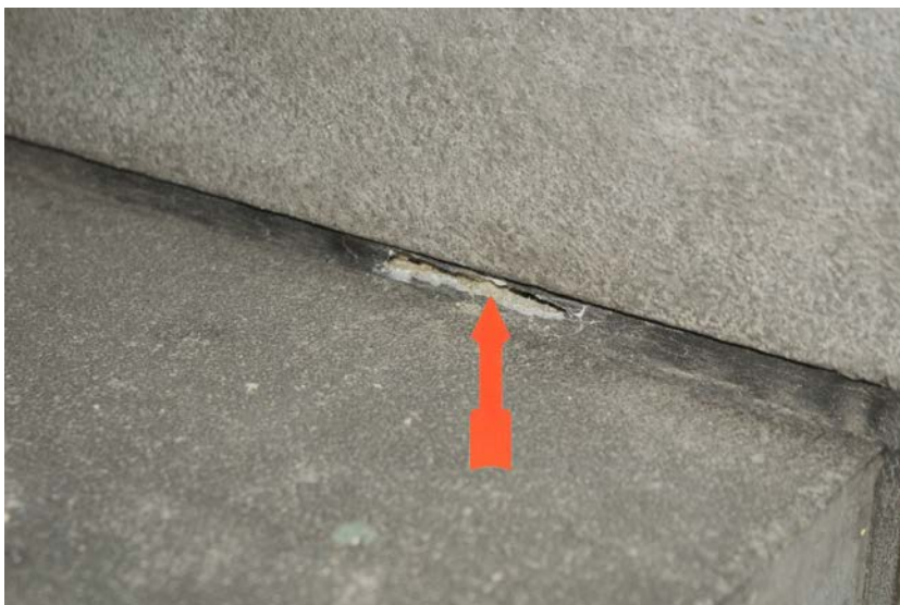
Bild 4: Physik 2, EG Treppenhaus (Probe B), Fuge an Treppenstufen, Detailansicht.
