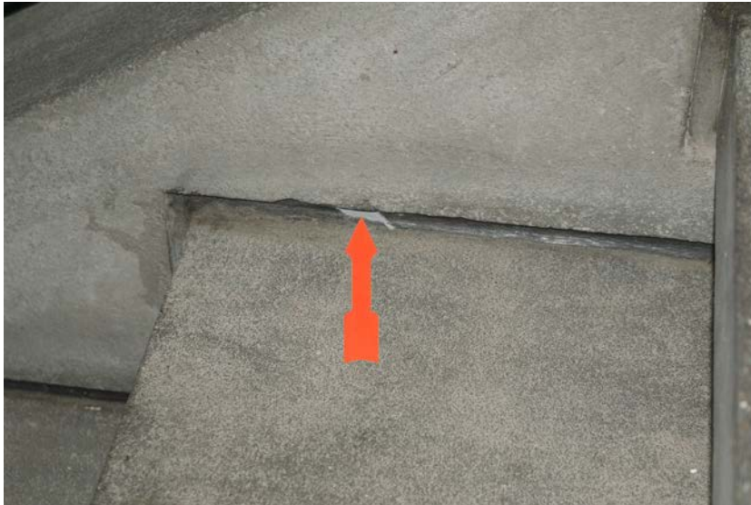
Bild 9: Physik 1, EG Treppenhaus (Probe F), Fuge an Treppenstufen.
